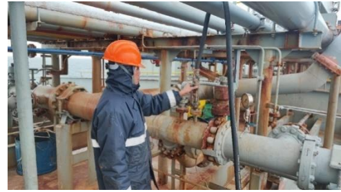
Gambar 5. Menghubungkan Steam Langsung ke Cargo Line
