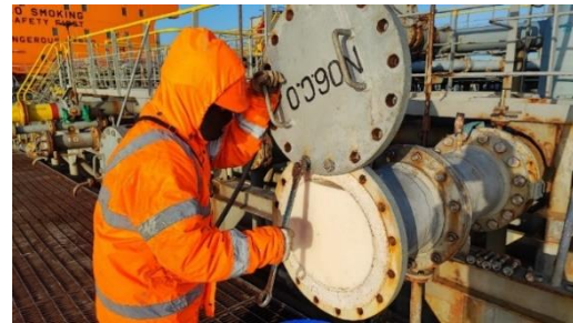
Gambar 6. Kondisi Manifold saat pengecekan
